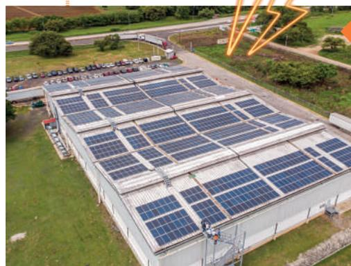
Instalamos 1.333 paneles solares en el Centro de Distribución (CEDI) de la empresa panameña Dicarina. La capacidad es de 360 kWp y representa un 51% de producción de energía fotovoltaica aproximada al año. Con este sistema la compañía dejará de emitir 152 toneladas al año de CO<sub>2</sub>.
